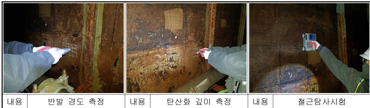
【사진 12.57】 지도능곡 재료시험 전경
